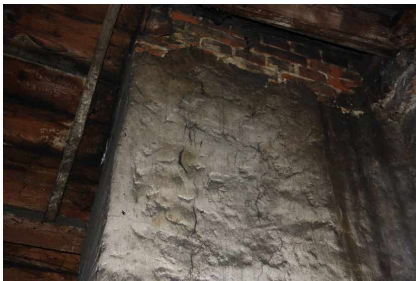
Fot. 4. Zarysowania widoczne na jednym z kominów (przy ścianie frontowej) poniżej połąć dachowej.
