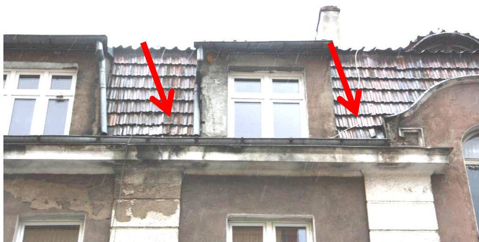
Fot. 2. Połąć dachowa – mansarda, nierówne pokrycie dachowe.
