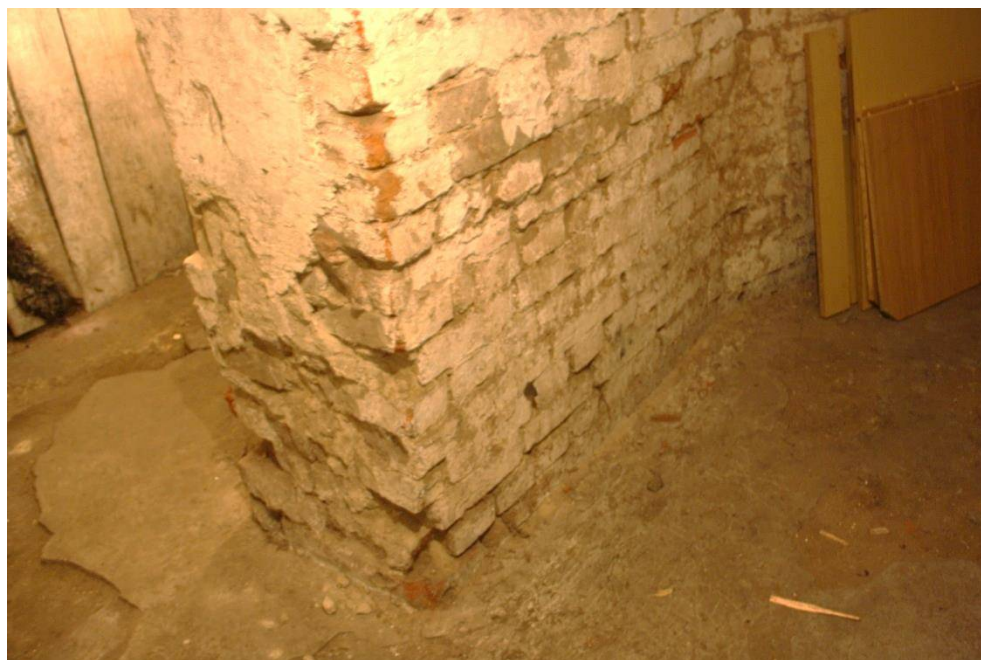
Fot. 1. Efekty długotrwałego zawilgocenia ściany piwnicznej.
